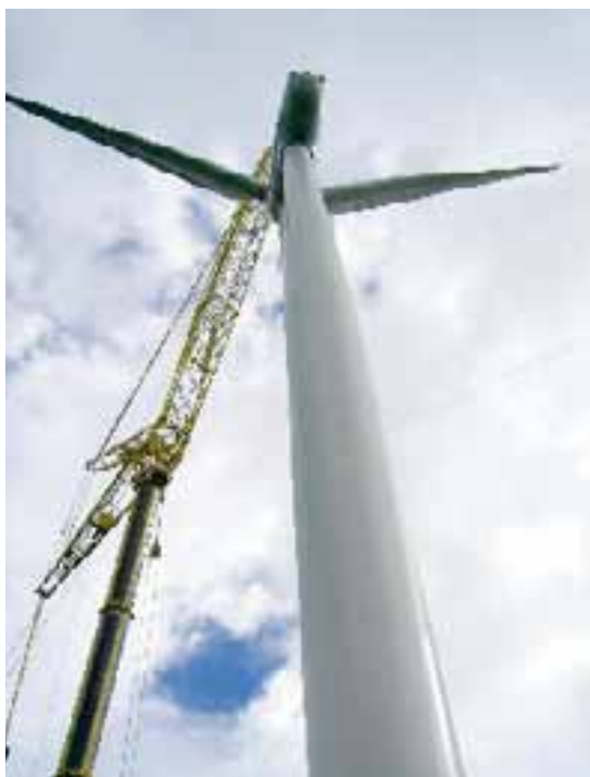
I augusti 2006 restes Morphics första egentillverkade vindkraftstorn utanför Östersund. Verket är 70 meter högt och har en effekt om 1 MW.
