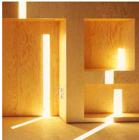
Sovboxarnas utsida kläs med ett enkelt skivmaterial med skarpa möten. (Auditorium, Köpenhamn. Ark. Entasis Arkitekter)
