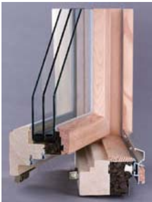
Figur 7.13 Tvärsnitt genom ett passivhusfönster.
