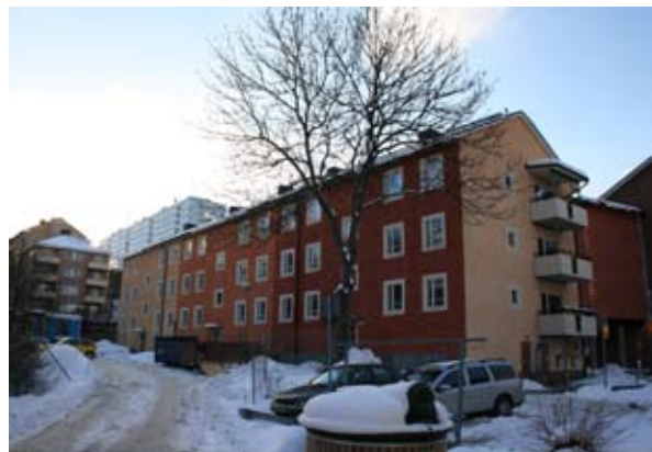
1950-talsbebyggelse utmed Förvaltarvägen.
