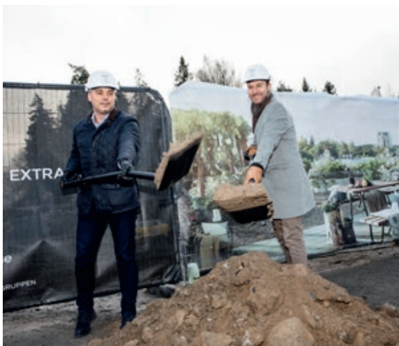
I december togs första spadtaget i projekt Unum av Johan Algernon, kommunalråd i Täby kommun och Erik Karlin, vd på Tobin Properties. Unum omfattar 148 studiolägenheter vid Roslags-Näsby i Täby.
