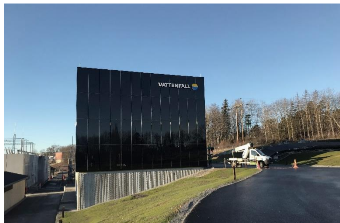
Vattenfalls transformatorstation i Järva, Stockholm
