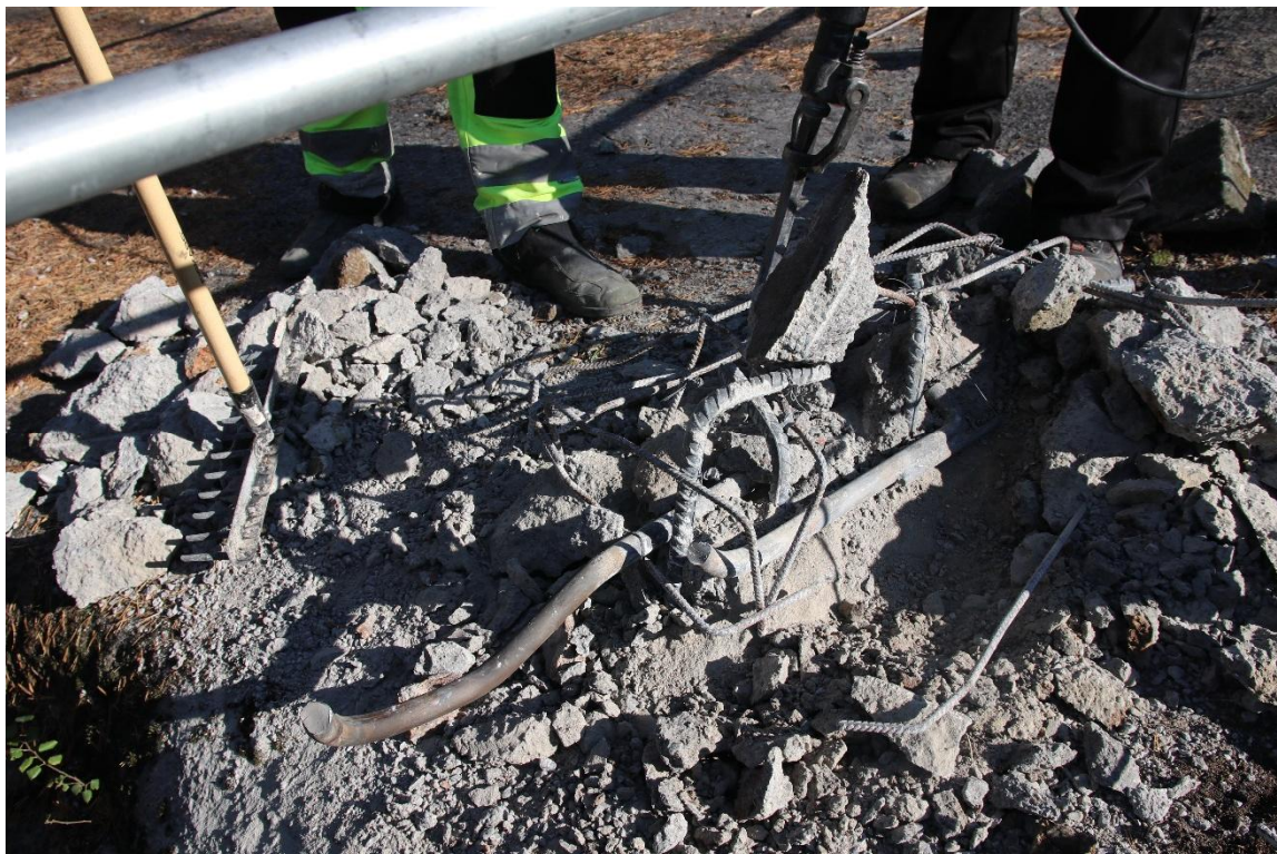
Kuva 22 piikkauksen edetessä paljastunut ankkuritangon sijoittelu.
