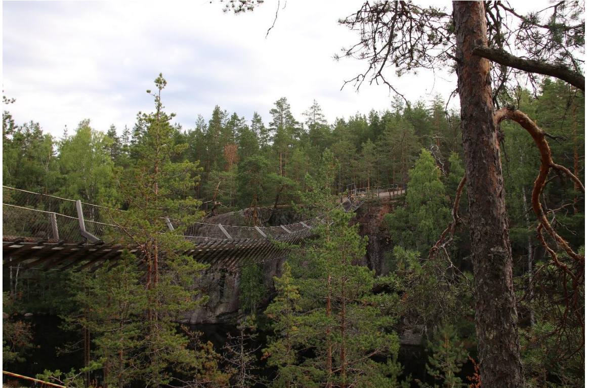
Kuva 2 Yleiskuva sillasta sen eteläpuolelta.
