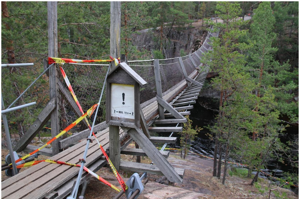
Kuva 11 Yleiskuva sillan päällysrakenteesta ja kaiteista.
