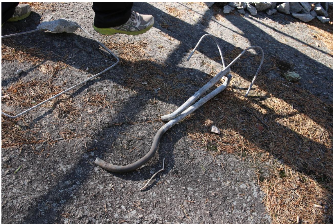
Kuva 25 katkennut ankkuritanko kahdessa osassa.
