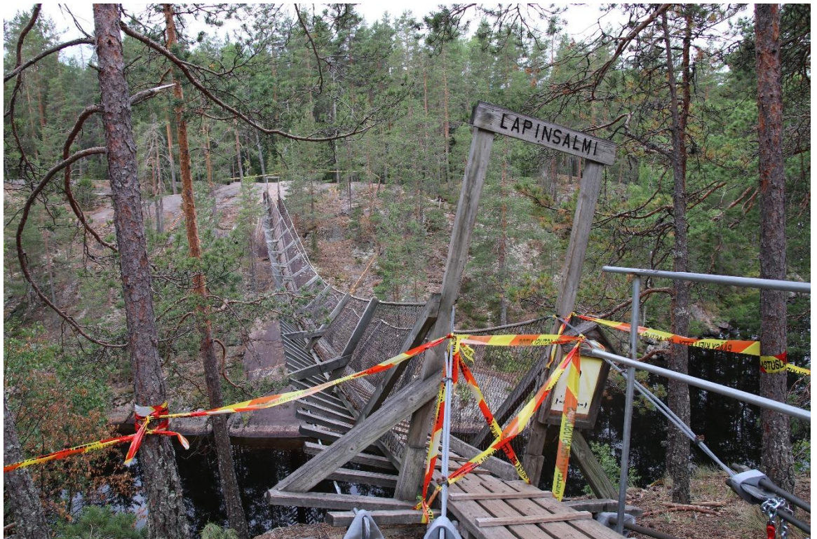
Kuva 4 Yleiskuva sillasta kohti länttä.
