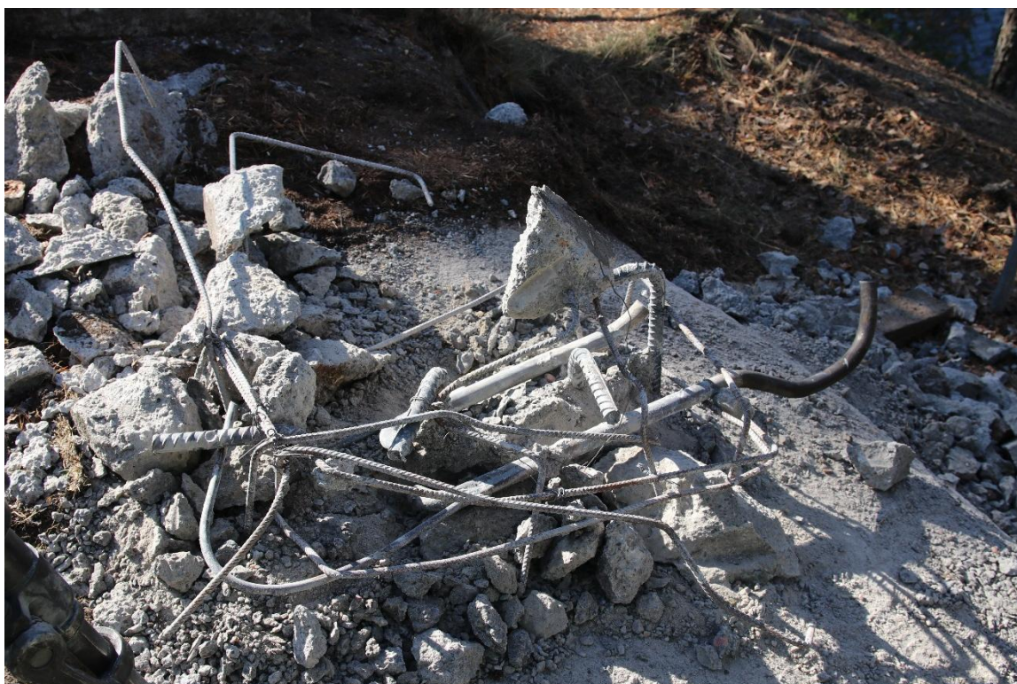
Kuva 23 piikkauksen edetessä paljastunut ankkuritangon sijoittelu.
