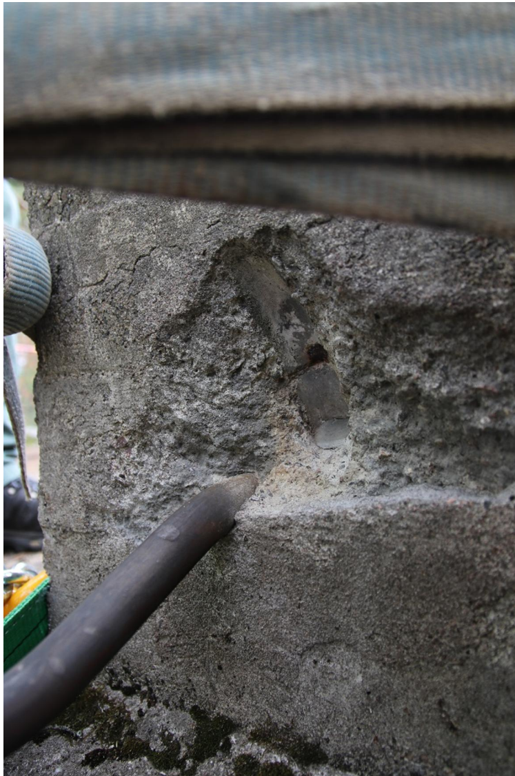
Kuva 31 Ankkurointitangon asento vastapainossa on suunnitelmapiirustuksista poikkeava.
