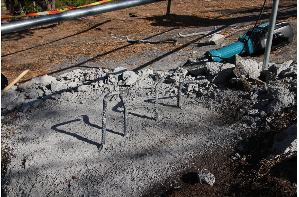
Kuva 26 vastapainon harjateräksiset kallioankkurit.
