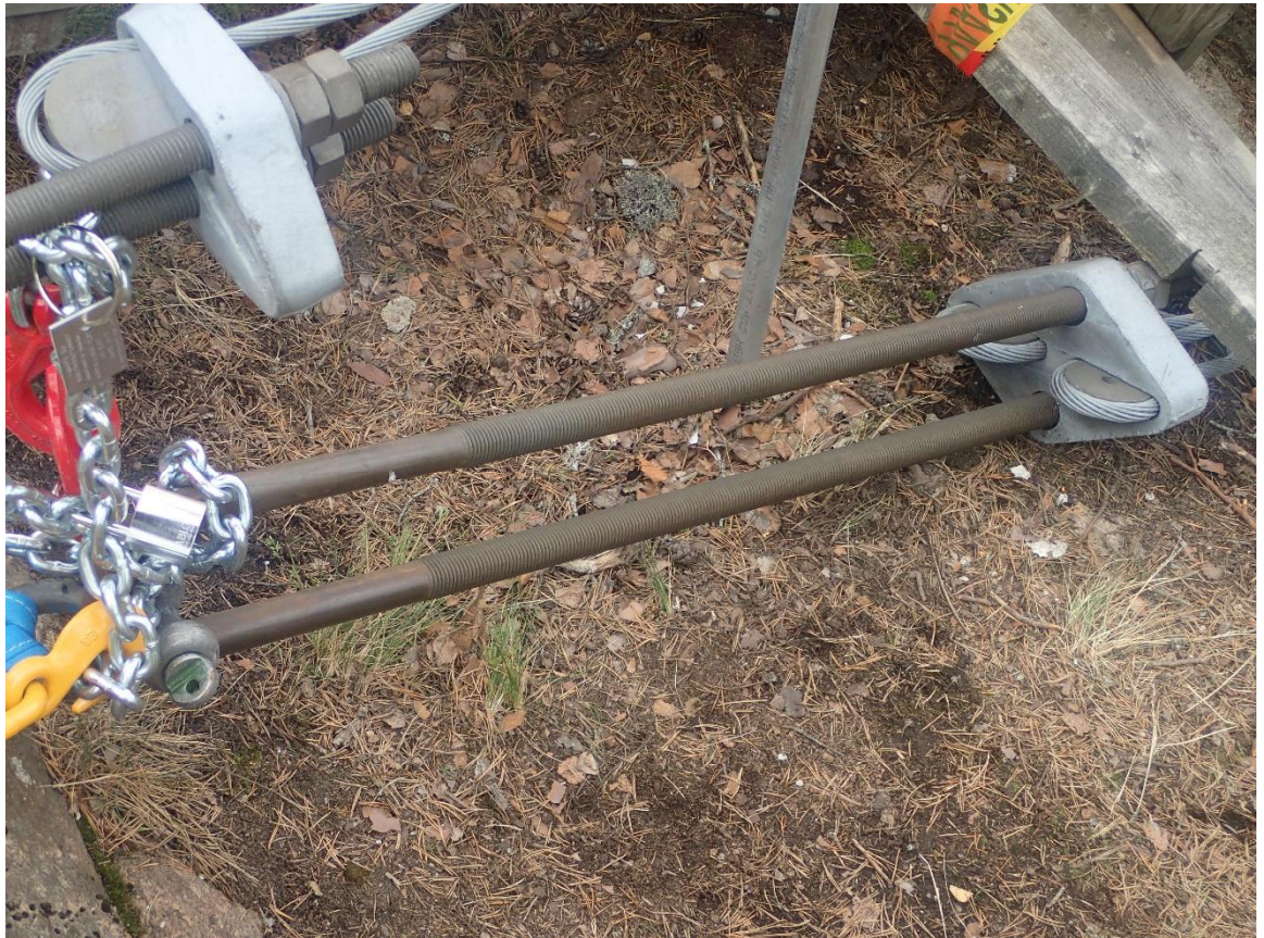
Kuva 21 Riippuköysien teräslenkkinen lievää ruostumista.
