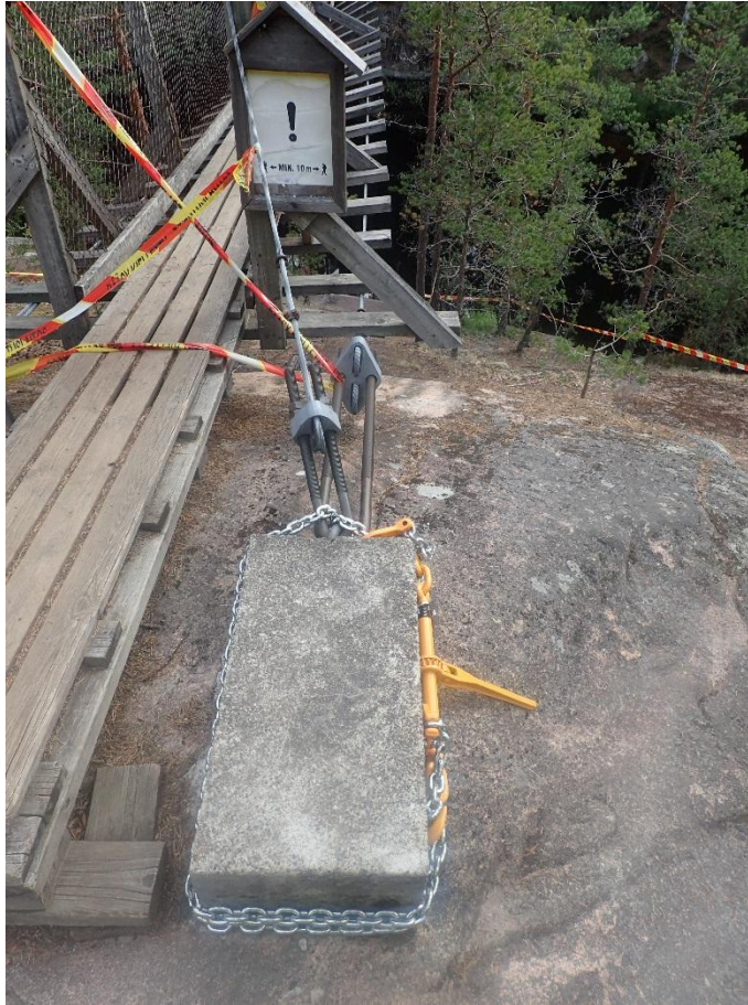
Kuva 7 Sillan länsipään eteläinen vastapaino.
