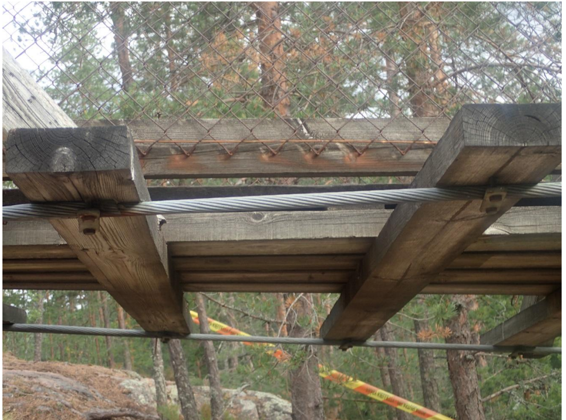
Kuva 10 Riippuköysien kiinnitysdetalji puisiin poikkikannattajiin.
