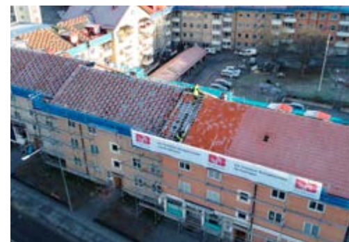
Renovering av de äldre delarna av Växtriket.
