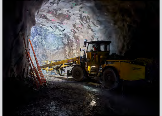
KABELTUNNELEN SMESTAD-SOGN i Oslo for Statnett. Tunnel-, grunn- og betongarbeider i det som er verdens første fossilfrie tunnelprosjekt og Norges første fossilfrie anleggsprosjekt.
