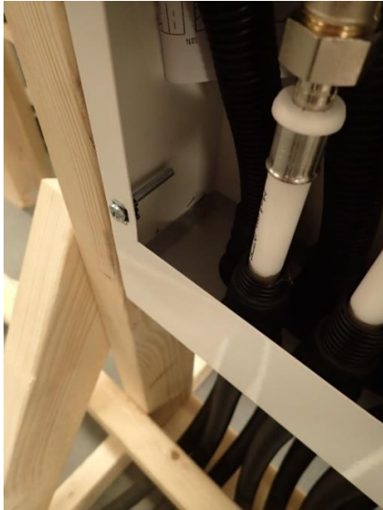
Figur 2: Fördelarskåp med 30 mm vattenpelare på botten.
