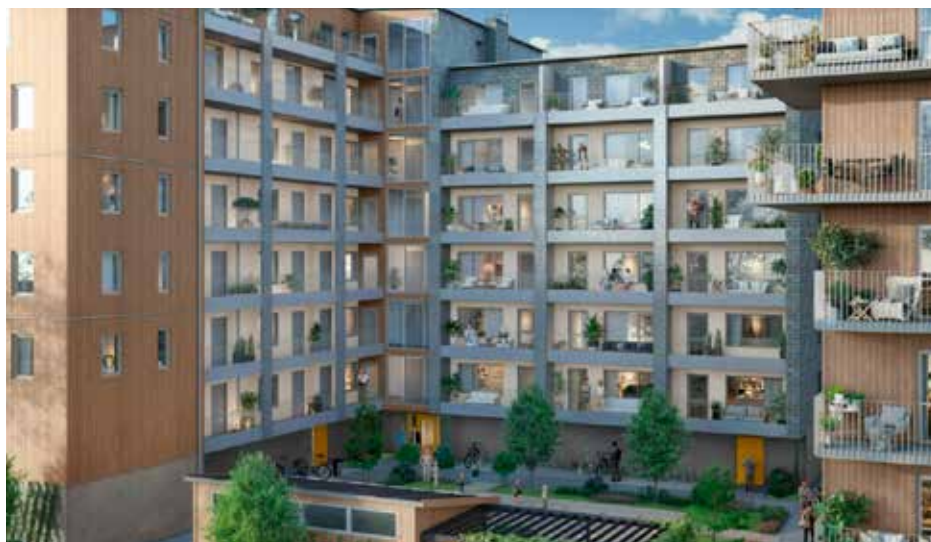
Kristianstad Bajonetten 3 Bostadsprojekt om 94 hyresbostäder i centrala Kristianstad. Beräknad inflyttning i början av 2023.
