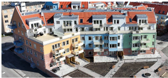
Kv. Hercules norra hus med rakt väggliv på tredje våningen och balkongräcke på terrasserna
