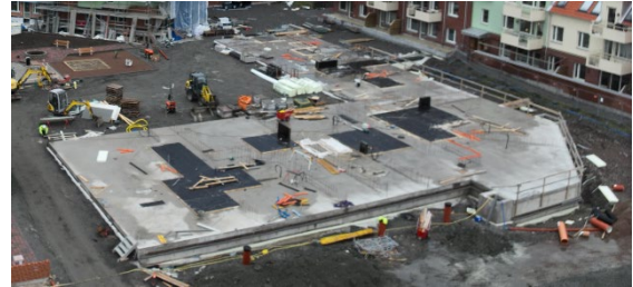
Grunden för Kv. Hercules södra hus januari 2025
