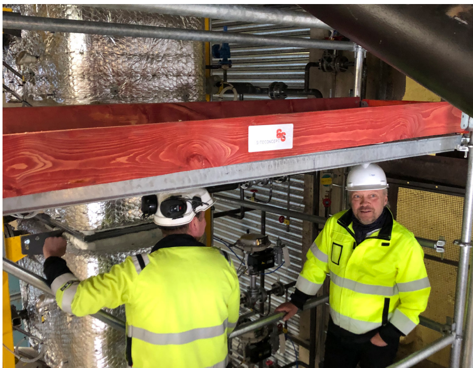
Arbetet med att färdigställa pilotanläggningen i Stockholm går enligt plan.
