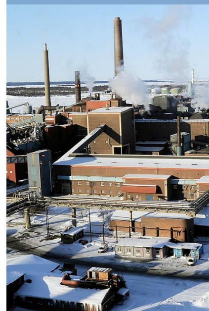
Vintervy över E-kalldoverket i Rönnskär.
