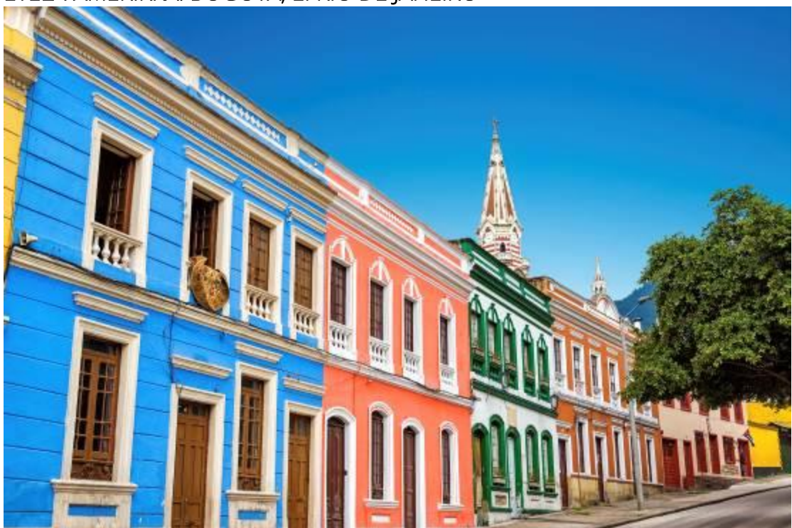
La Candelarian alueen siirtomaa-aikaisia rakennuksia.
