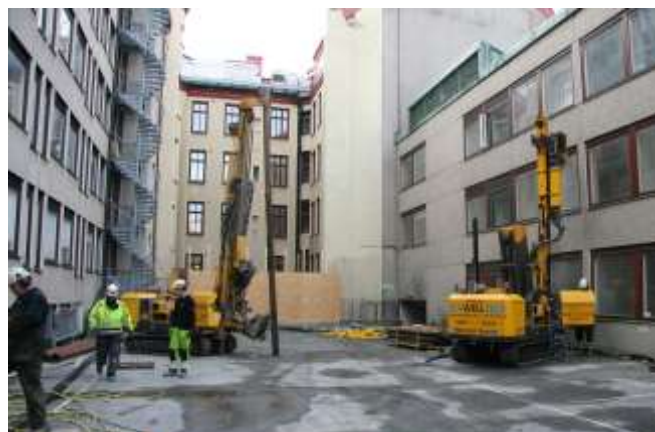
Här borrar för bergvärme till Wallenstams fastighet på Avenyn 29-35. På 300 meters djup i berglagret hämtas geoenergi till en energicentral som i sin tur drivs av Wallenstams vindkraftsel.
