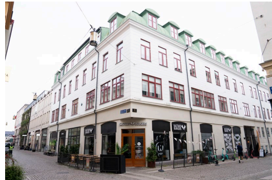
Affärsjuridiska byrån Morris Law har tecknat avtal om 1 500 kvadratmeter i Wallenstams fastighet på Södra Larmgatan 11 i Kvarteret Victoria, Göteborg. Inflyttningen planeras till december 2026.
