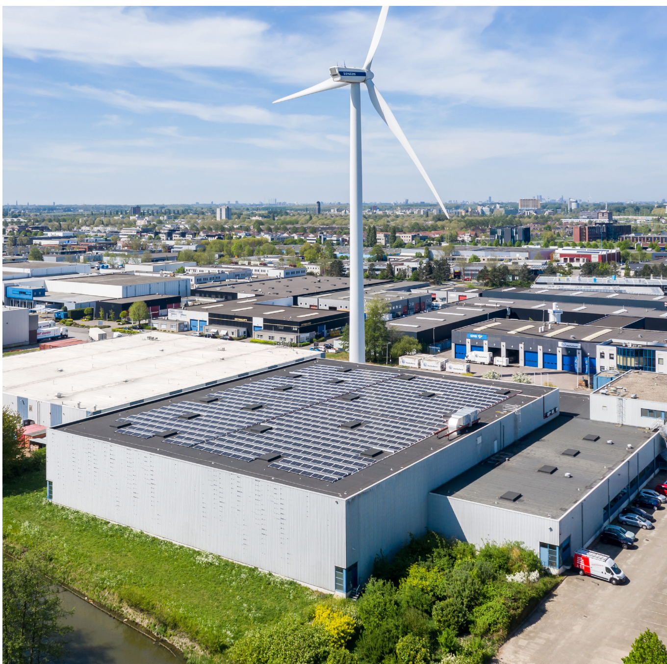
På Chromstraat 140 i Nederländerna har Sagax färdigställt en solcellsanläggning som producerat 331 MWh under 2021. Den årliga elproduktionen motsvarar två miljoner kilometer med elbil. Fastigheten omfattar totalt 7 200 kvadratmeter uthyrningsbar area och är fullt uthyrd.
