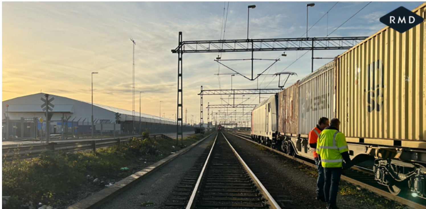
Installation av PMU:er i Skandiahammen, Göteborg.
