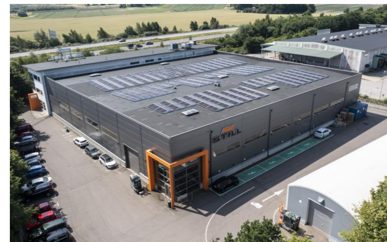
Fastigheten Stenåldern 6 i Malmö.
