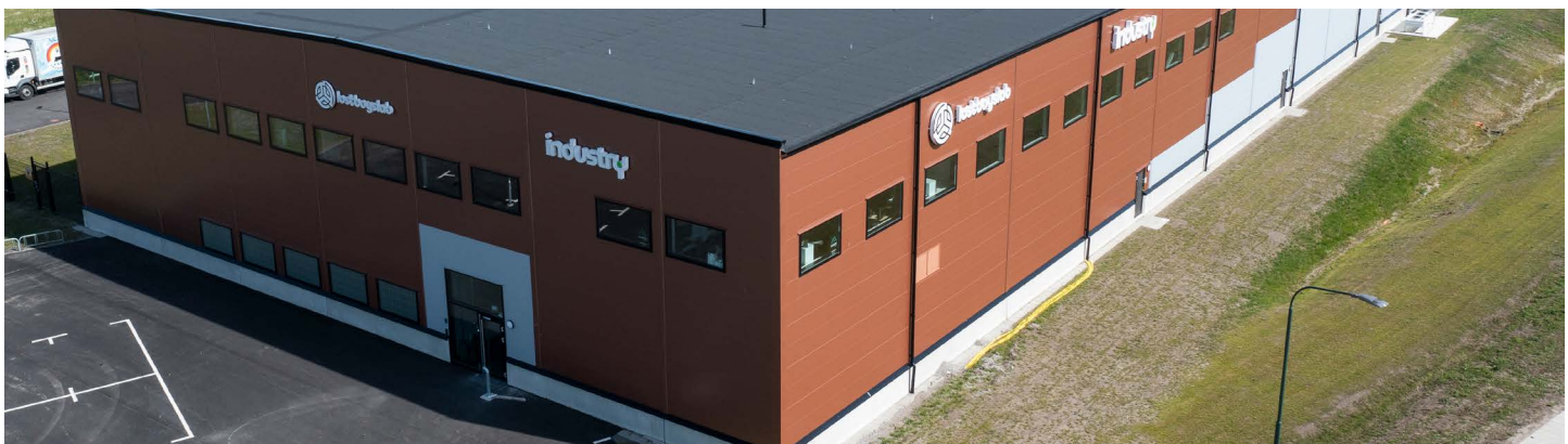
Fastigheten Hoven 1 i Malmö.
