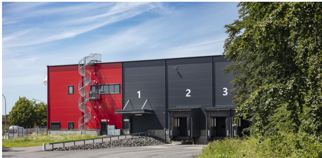
The property Ättehögen Östra 6 in Helsingborg.
