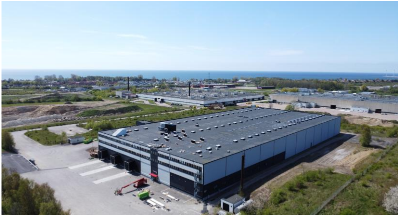
Fastigheten NIO-E 3 i Trelleborg.
