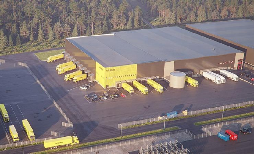
Fastigheten Stigamo 1:42 i Jönköping.
