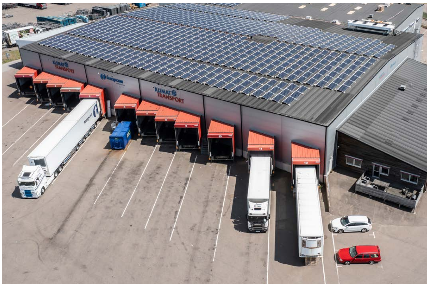
Fastigheten Kolven 4 i Helsingborg.
