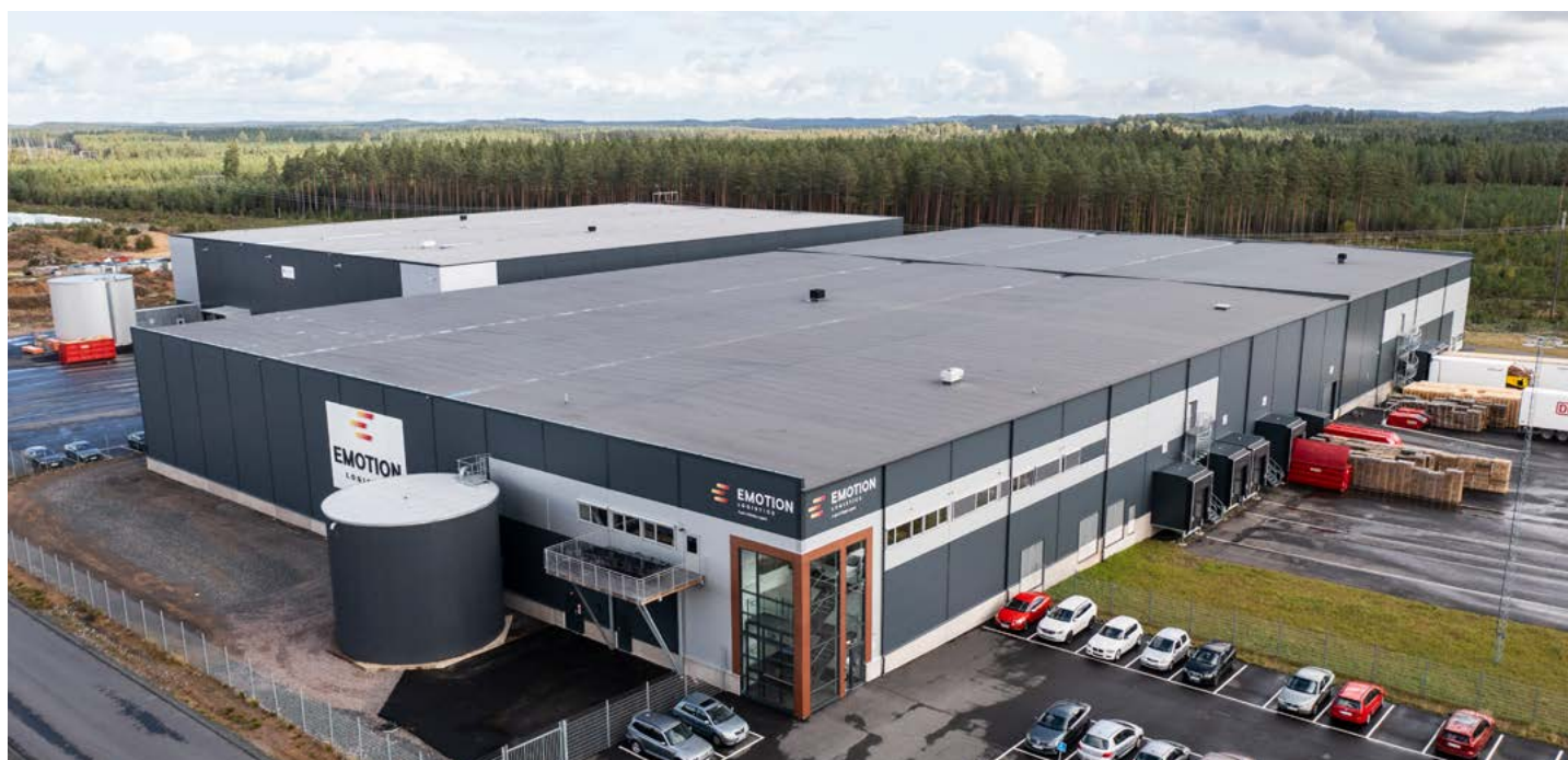
Fastigheten Stigamo 1.46 i Jönköping.
