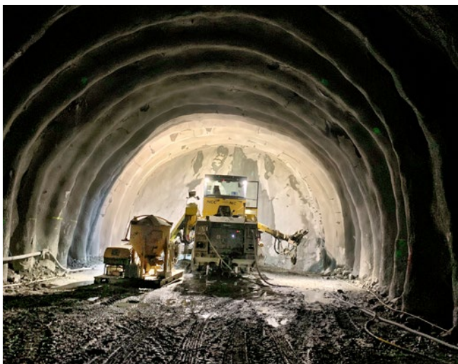
Sprängningsarbete i ett av tunnelloppen vid Breivika.
