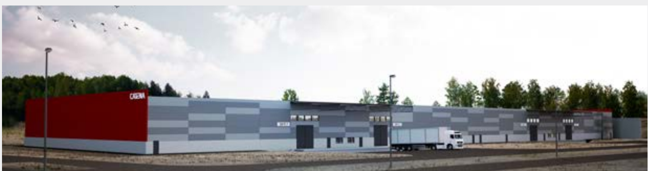
Volymterminal, Katrineholm, under uppförande
