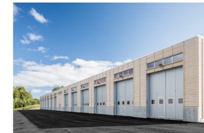
Sömmerskan 3, Skellefteå Tillträde: November 2021 Fastighetens area: 11 040 kvadratmeter
