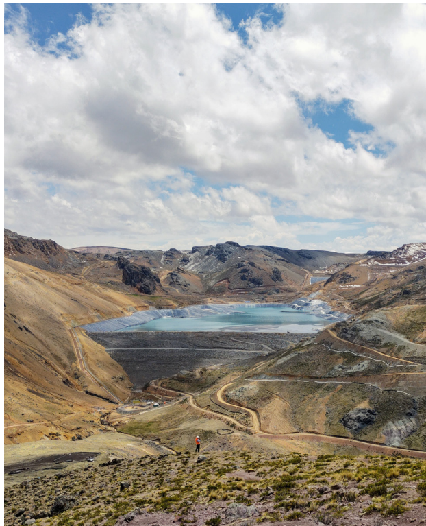
Gruvindustrin - inte minst den i Latinamerika - befinner sig i en expansiv fas samtidigt som nya lagar ställer krav på förbättrad rening också i befintliga anläggningar. Här finns stora möjligheter för Axolot.
