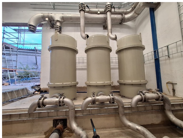
Under tredje kvartalet 2025 levererades o installerades samtliga åtta AxoPur reaktorer som utgör kärnan i den rekordstora anläggning som just nu byggs hos Aspa Bruk. På bilden syns tre av dem.
