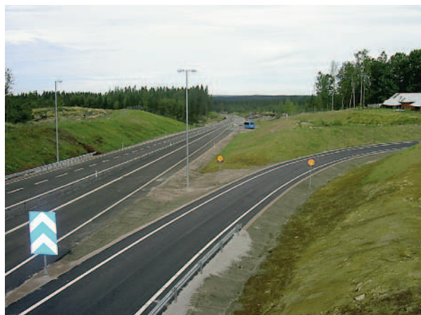
Vecon bygger ny vei mellom Kråkered og Aplared nær Borås. Arbeidene omfatter blant annet bygging av 6 km tre-felts vei og åtte broer.
