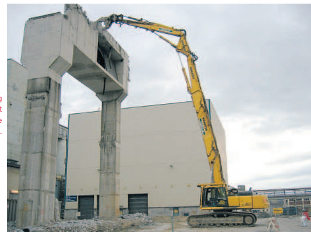
Riving av bygg og gjenvinning av avfall er et viktig forretningsområde i industridivisjonen.
