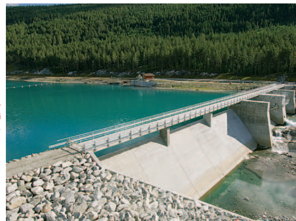
Dammen ved Heggebottvatnet er en del av kraftverkutbyggingen i Øvre Otta i Oppland.
