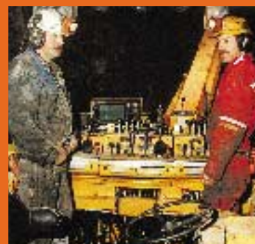
Veidekke er engasjert på anlegg i Norge og i utlandet. Ved ombyggingen av Käppalaverket renseanlegg i Stockholm samarbeider Veidekke med det svenske entreprenørselskapet Siab. Anlegget har tatt i bruk meget avansert utstyr. På bildet ser vi tunnelarbeider Svein Skarsbø til venstre og reparatør Geir Johansen ombord i anleggets moderne halvdata-styrte borerigg.
