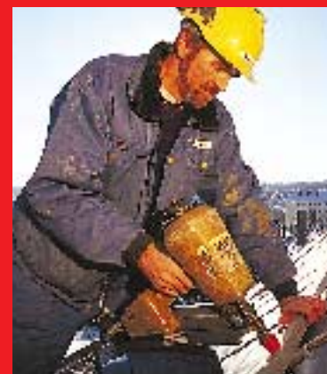
Markedet for rehabilitering er i vekst og er et viktig område for Veidekke. På bildet holder tømrer Arne Ronald Hansen på med å skifte ut taket på en av blokkene i Manglerud Borettslag i Oslo.
