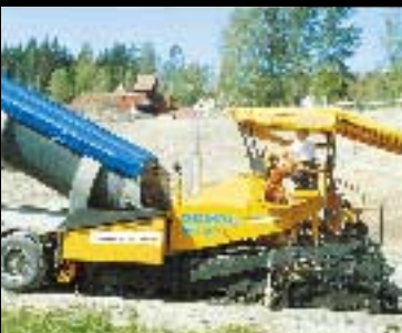
Utstyr for transport og legging av varmasfalt er blitt betydelig forbedret de siste årene. Det gir mer stabil kvalitet, bedre slitestyrke og jevnere asfaltdekke.
