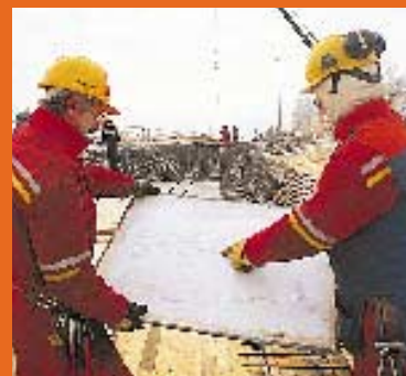
Veidekke har satt fokus på aktivt engasjement fra alle arbeidstakere på arbeidsplassen. På bildet er forskningsnekker Terje Furuli til høyre og tillitsmann John Helge Steinfeld i ferd med å studere tegninger ved Langeland bru. Denne brua inngår i den 10,3 km lange parsellen Arteid Bru-Kverndalen på Gardermobanen.
