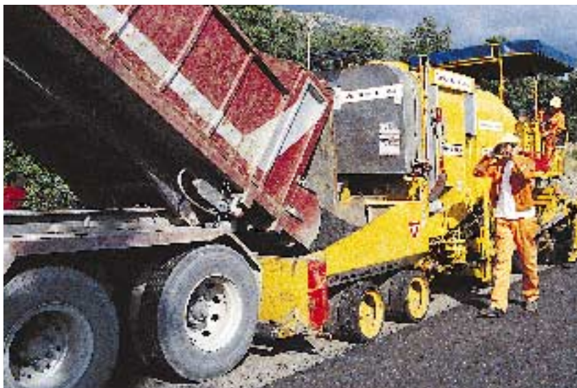
Produksjonsutleggeren «Mix Paver» gjør som navnet indikerer: Den både blander og legger asfalt i samme operasjon, og er vår mest etterspurte maskin for kaldasfalt og gjenbruk av asfalt.
