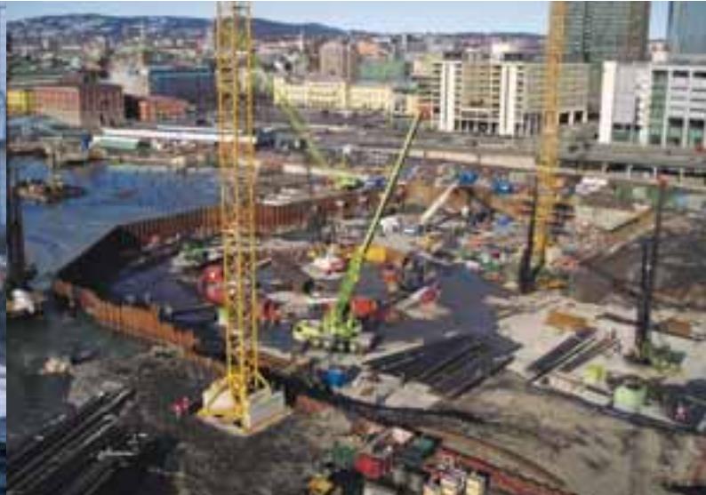
Grunnarbeidene for den nye operaen i Oslo ble igangsatt i 2003.
