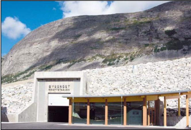
Øyberget Kraftstasjon, Øvre Otta
