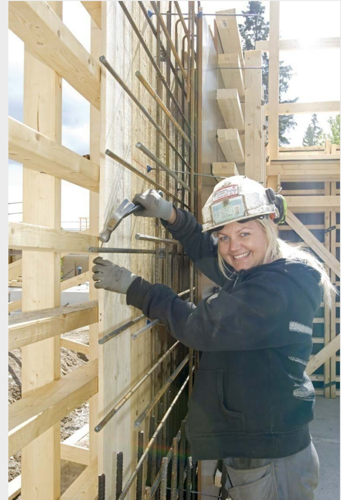
Kirsti Flatabø avlegger betongfagprøven på Årvollbrinken
