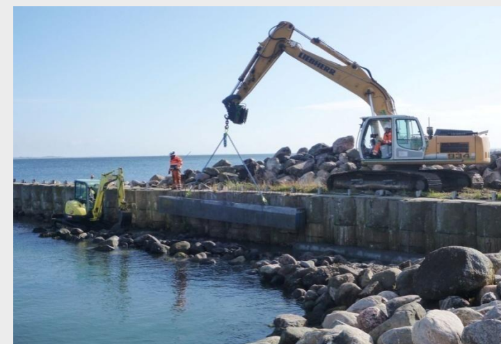
Renovering av fergeleie Bøjden - Fynshav
