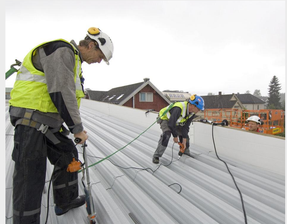
Montering av takplater på ny butikk for Rema 1000 i Hokksund
