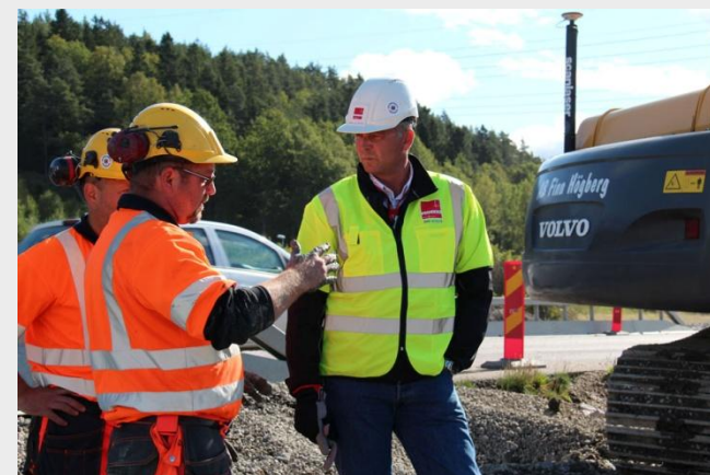
Arbeider i gang på E45 sydvest for Trollhättan
