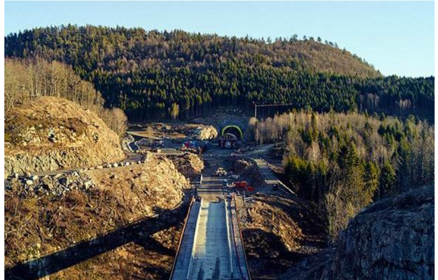
Ny jernbaneparsell på Vestfoldbanen under oppføring
