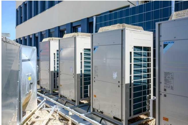
*Im gewerblichen Bereich werden zur Klimatisierung sogenannte VRV/VRF Systeme verbaut. Diese Luft-Luft-Wärmepumpen sind Allroundtalente, denn Sie können kühlen, heizen und Warmwasser aufbereiten. © Daikin*
