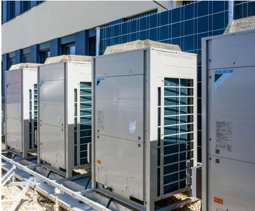
Mit der Einführung des GEG lässt sich der Einsatz von Luft-Luft-Wärmepumpen und hier im Besonderen der Daikin VRV zur Beheizung und Kühlung von Gewerbeimmobilien nun wesentlich einfacher realisieren. © Daikin
