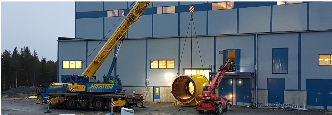
Kvarndelar på väg att monteras i anrikningsverket
