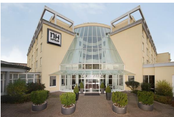
Im neuen Anlitz: kürzlich renoviertes NH Weinheim.
