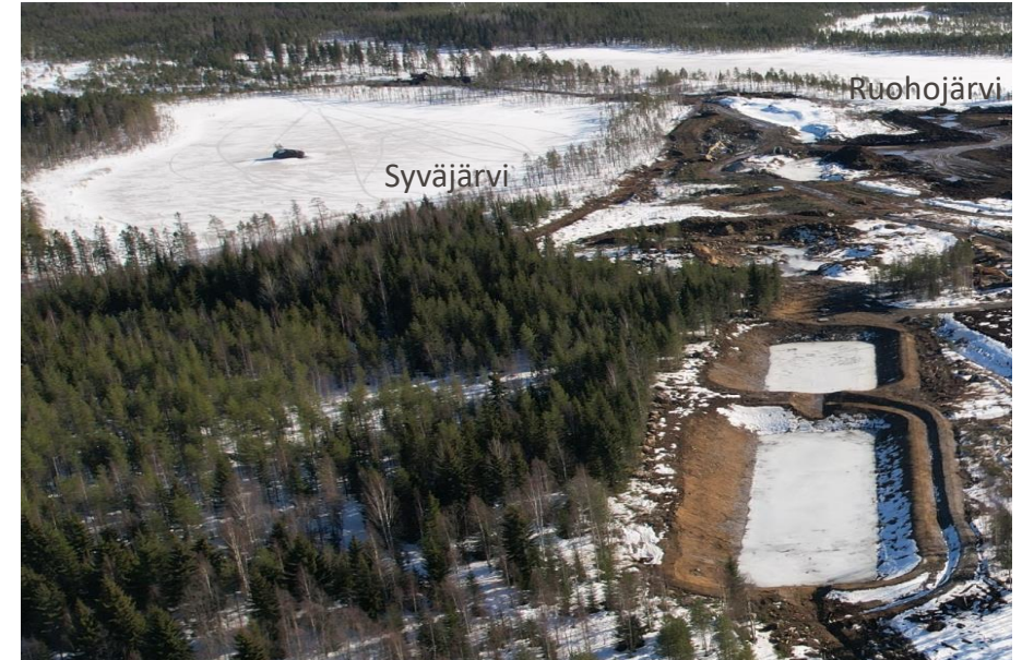
Syväjärven kaivosalueelle rakennetut laskeutusaltaat.
