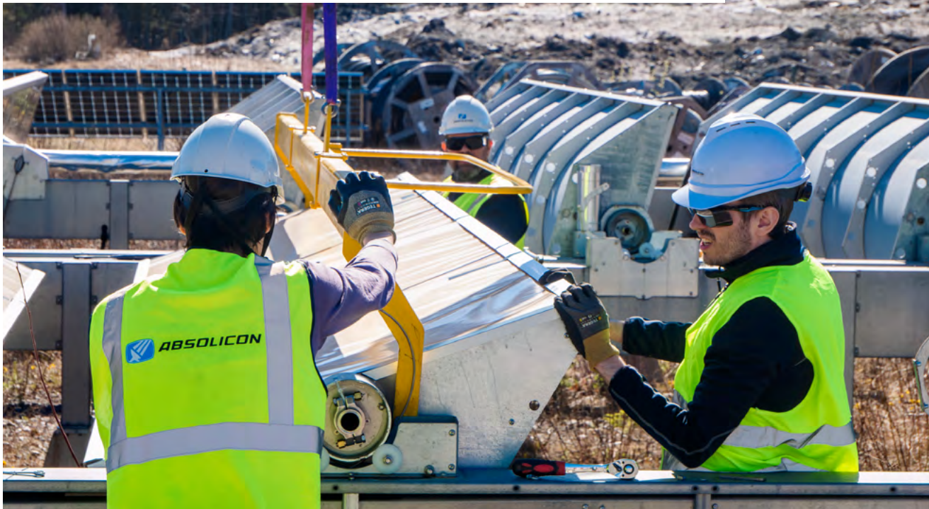
Solfångare för högre arbetstemperaturer installeras på en testanläggning i Härnösand för att utvärderas under sommaren. Foto: Erik Björkland.
