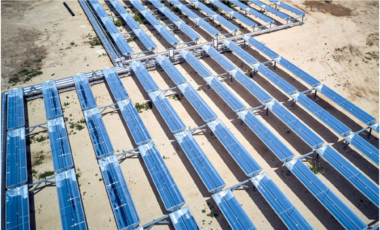
Absolicons koncentrerande solfångare ska i UNIDO-projektet "Coal Zero by Green Steam" kombineras med värmepumpar, energilager och ångkompression. Bilden visar solfångarfält i Bari. Foto: Absolicon
