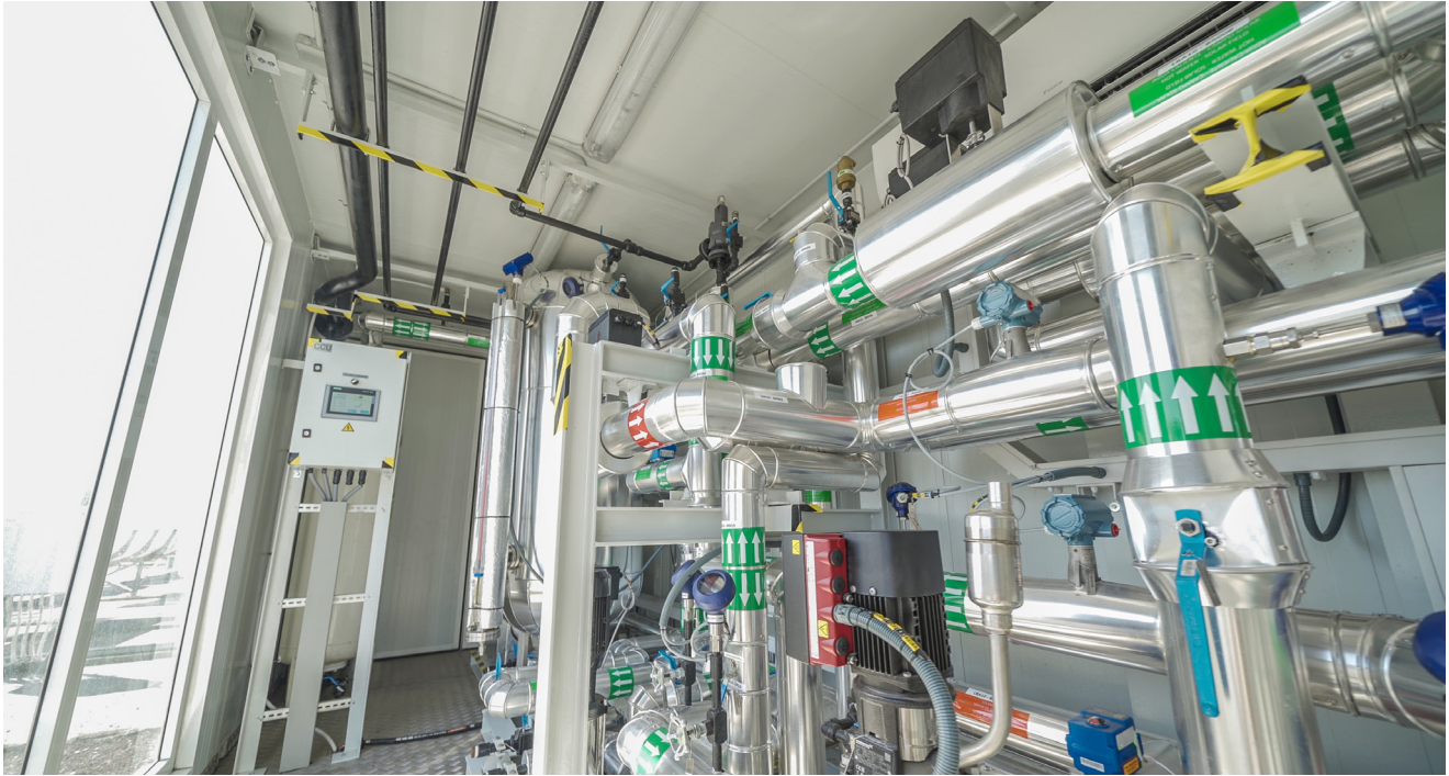
Absolicons solvärmecentral som producerar ånga hos ITC på Gran Canaria.
