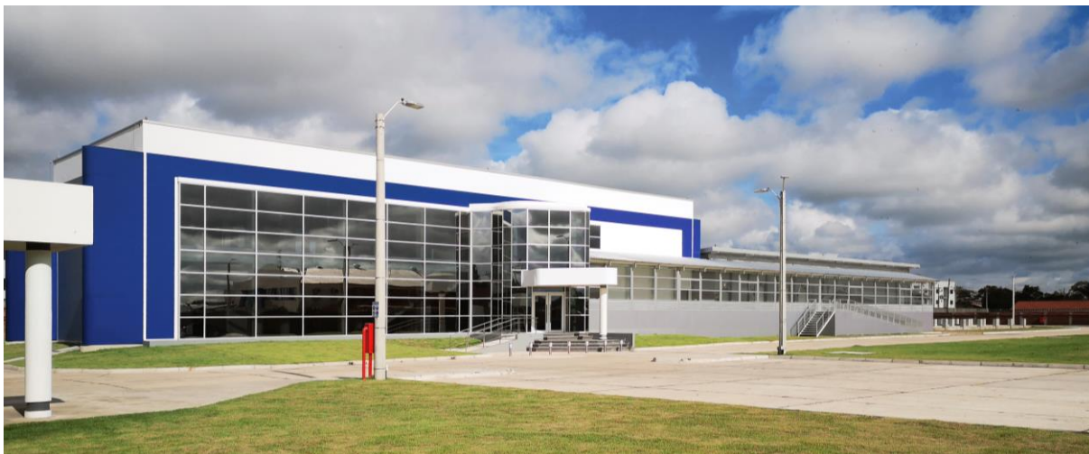
Flexenclosure eCentre datacenter för Tigo i Bolivia
