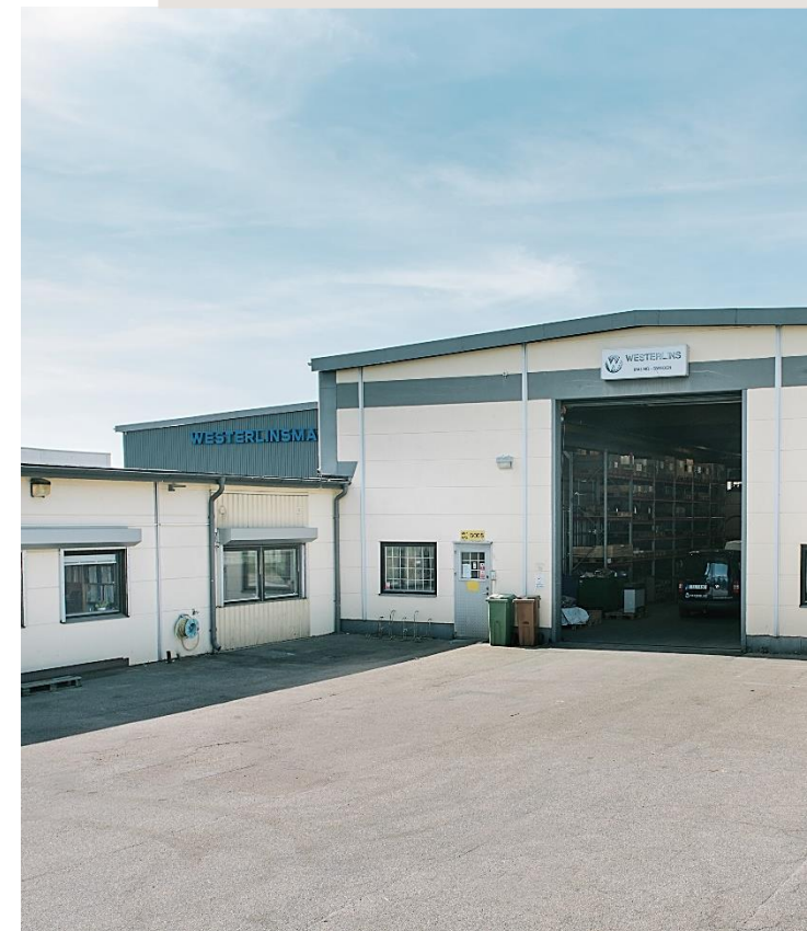
Fastigheten Flintkärnan 4 i Malmö, industri.
