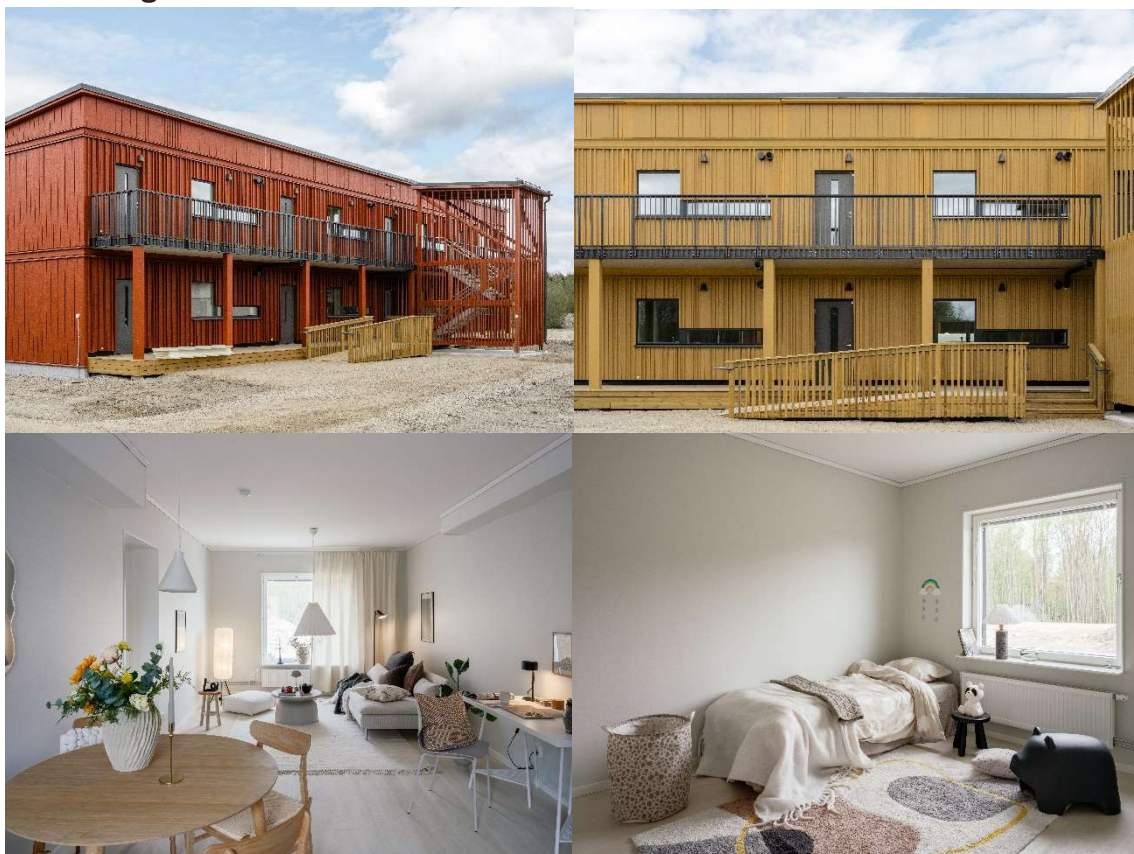
Exteriör och interiör av Parmacos dynamiska bostäder i Myckle, Skellefteå. Foto: Jonas Westling/Parmaco
