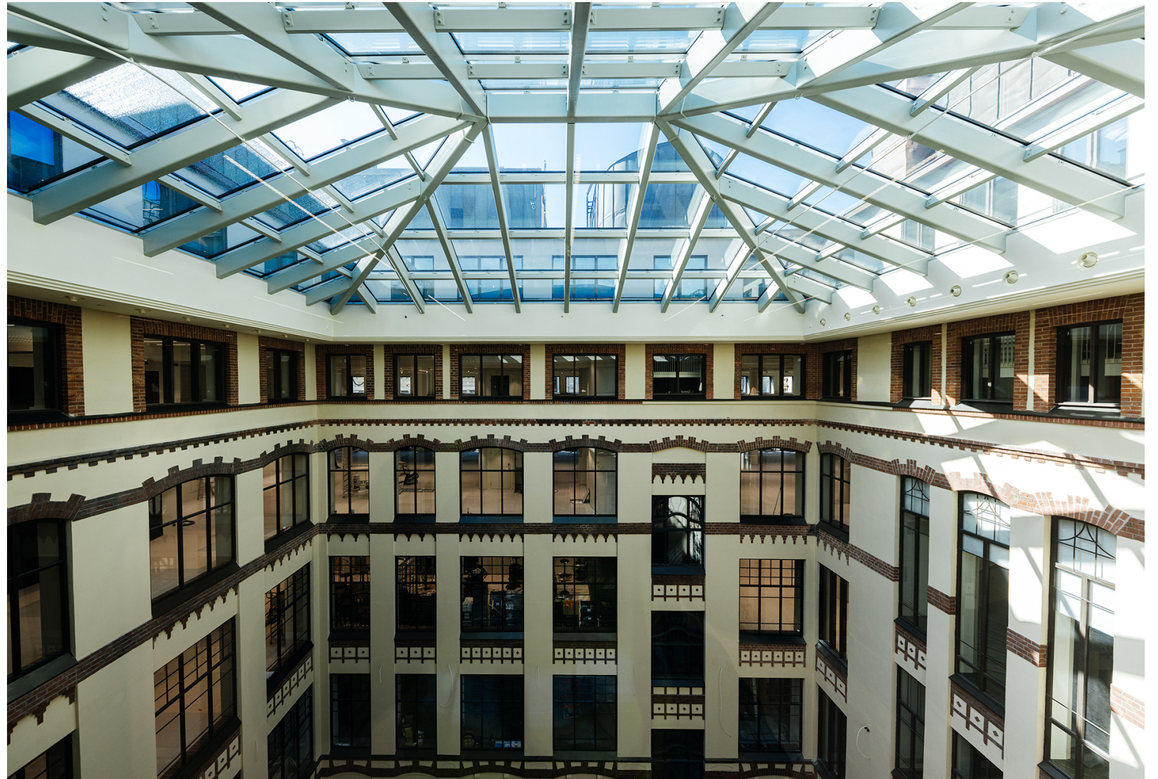
Aleksanterinkatu 13 -kiinteistön peruskorjaus, Helsinki
