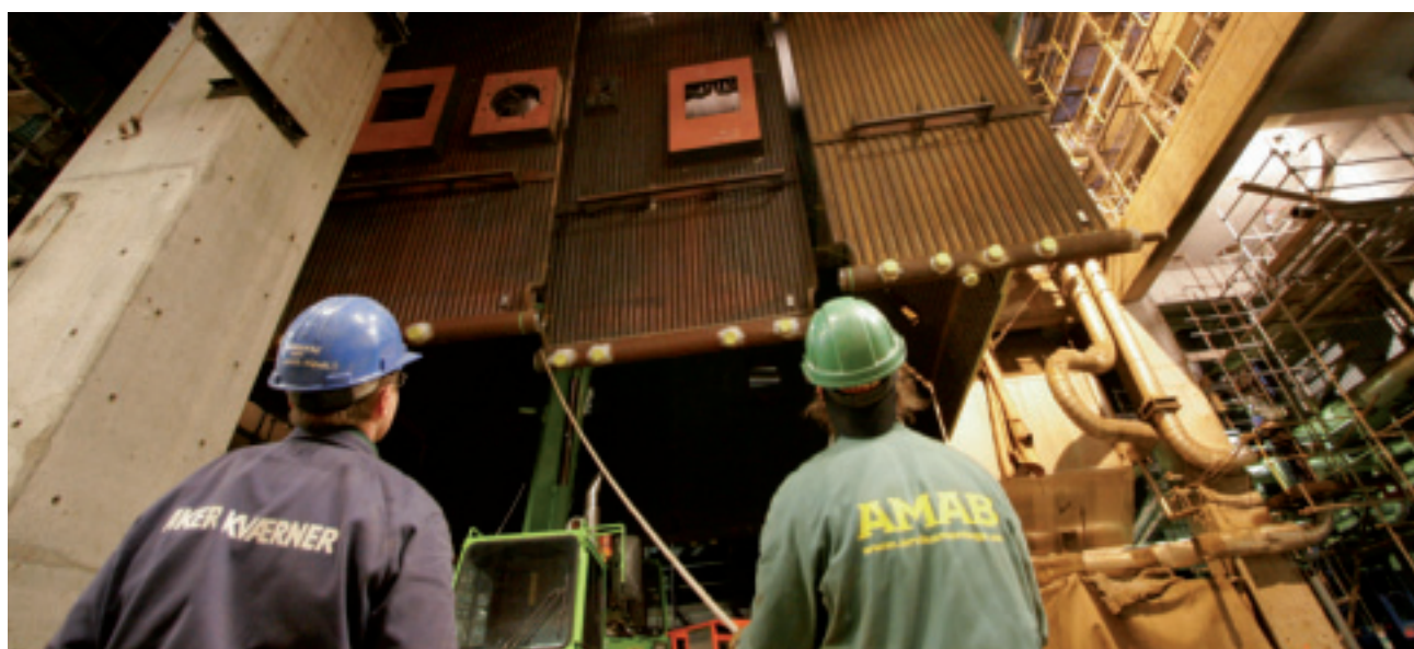
Skoghallin tehtaot investoi energiahankkeeseen, johon sisältyi öljykäyttöisen kattilan muuttaminen biopolttoainekattilaksi.
